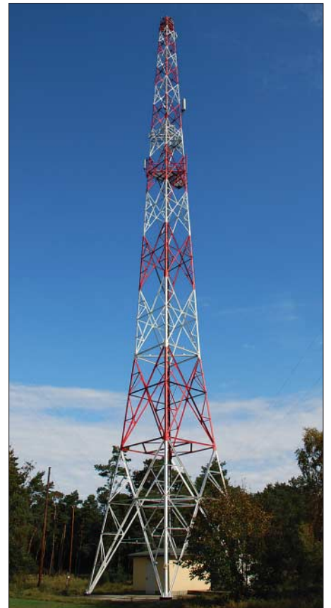
Bild 3: 70 m hoher Antenträger; die Ionosonde befindet sich in dem Häuschen auf dem Mastsockel
