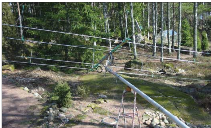
Bild 1: Der Richtstrahler in fortgeschrittenem Baustadium; dank Kippgelenk sind alle Elemente bequem zugänglich.
